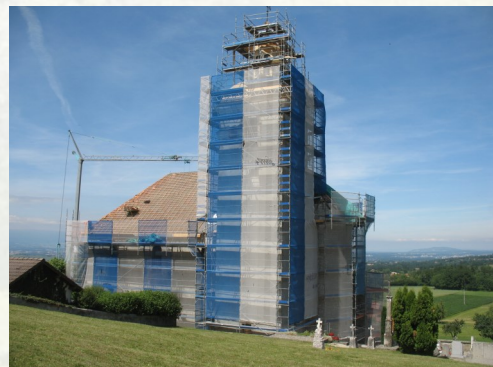
Le chantier de l'église avance...
