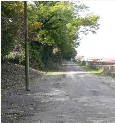
VC 11 : avant les travaux
