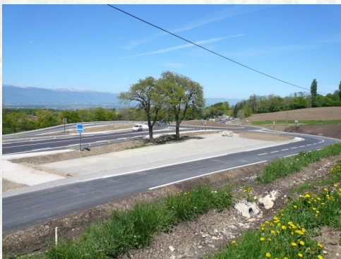
La bretelle de Pomier terminée
