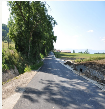
VC 11 : après les travaux
